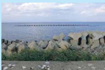
野付半島における海水面と同じ高さの消波ブロック
