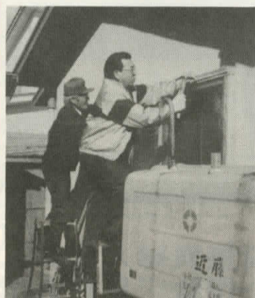
冬に備えて目張り作業
