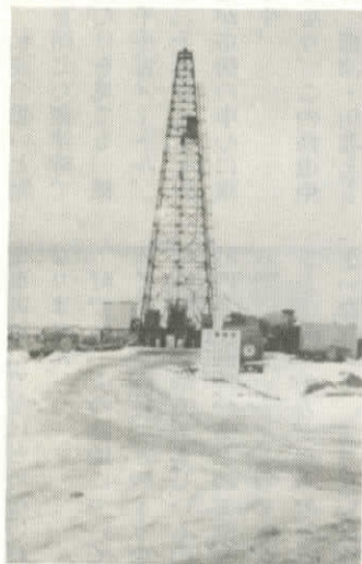
温泉試掘ボーリング現場
