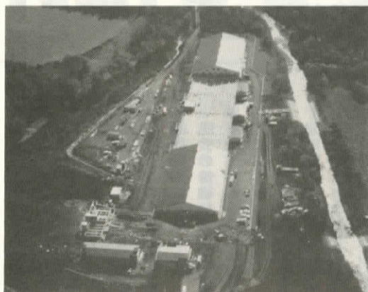
昨年完成した標津川サケ・マスふ化場(川北)
