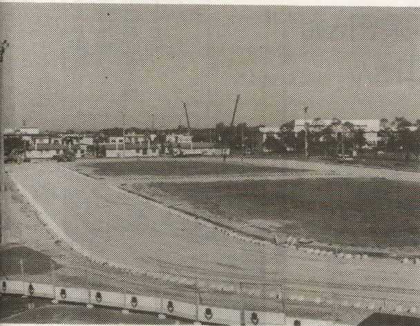
工事が進む町営スケートリンク
