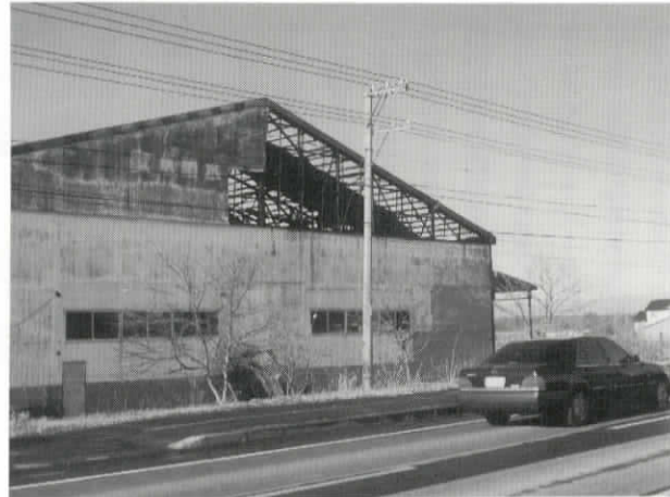
国道244号線沿い、伊茶仁の屋根などが 壊れている建物
