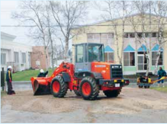
子どもたちのために重機で整地作業
