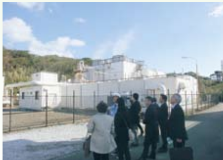
八丈島地熱発電所
