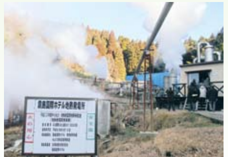
霧島国際ホテル地熱発電所（鹿児島県）
