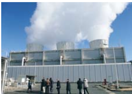
大霧地熱発電所（鹿児島県）
