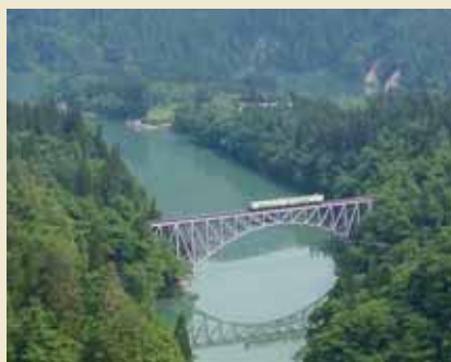
JR只見線と第一只見川橋梁
