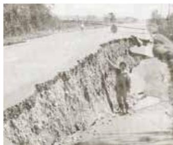
地震で崩壊した道路(町道茶志骨西7線)。M8.1の地震で、町内では大きな揺れと液状化現象で建物などへ大きな被害が出ました。
